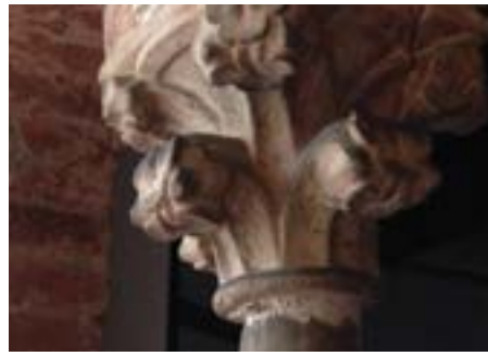
Particolare del capitello a crochet della bifora (vedi a lato).
