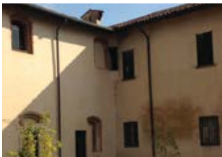
Vista da quello che un tempo era il cortile industriale. In alto spicca una finestrella angolare dalla quale il frate grangerio dominava ogni lato del cortile e, quindi, controllava i lavoranti.
