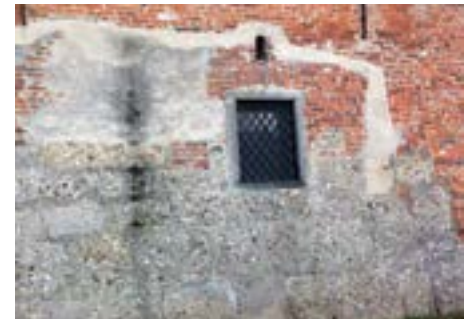
Parete esterna nord del primo edificio: massi di conglomerato che costituivano il basamento della casa colonica che i primi Umiliati hanno riadattato a edificio residenziale.
