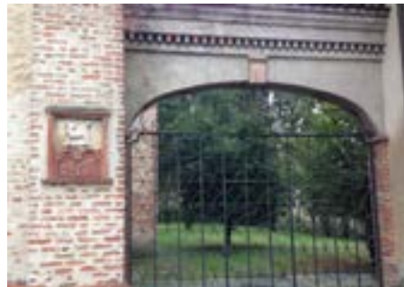
Prima area cimiteriale sul lato est della chiesa.
