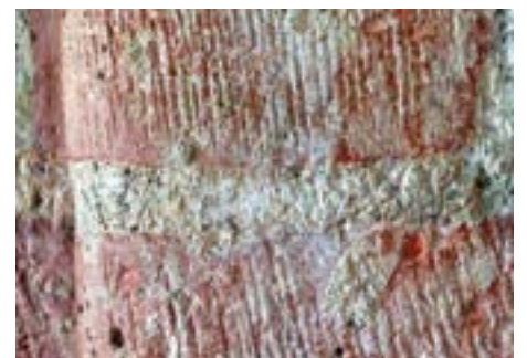
Accuratezza della rifinitura: strato sottilissimo di malta tra i mattoni e la decorazione a graffio della superficie esterna.
