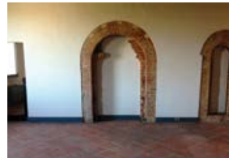
Al primo piano dell'edificio residenziale originario: resti della bifora e della monofora che si affacciavano sulla parete esterna ovest, nel locale adibito al dormitorio dei frati. E' probabilmente il reperto architettonico più antico del complesso abbaziale (1220, 1230 circa).
