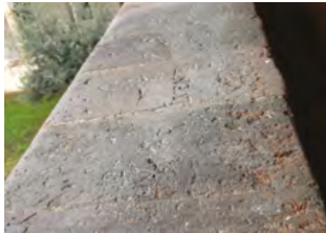
Angolatura del loggiato del chiostro, che rileva i numerosi graffiti presenti.
