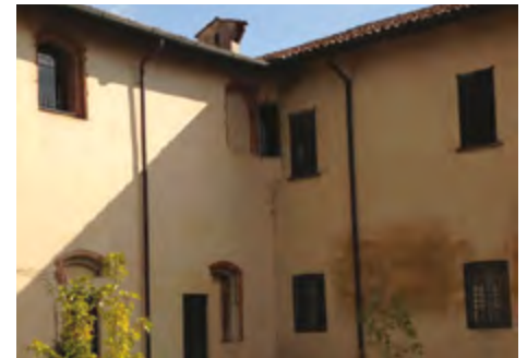
Vista da quello che un tempo era il cortile industriale. In alto spicca una finestrella angolare dalla quale il frate grangerio dominava ogni lato del cortile e, quindi, controllava i lavoranti.
