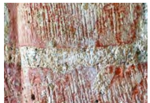
Accuratezza della rifinitura: strato sottilissimo di malta tra i mattoni e la decorazione a graffio della superficie esterna.
