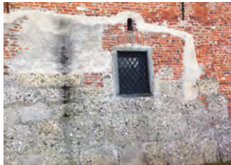
Parete esterna nord del primo edificio: massi di conglomerato che costituivano il basamento della casa colonica che i primi Umiliati hanno riadattato a edificio residenziale.
