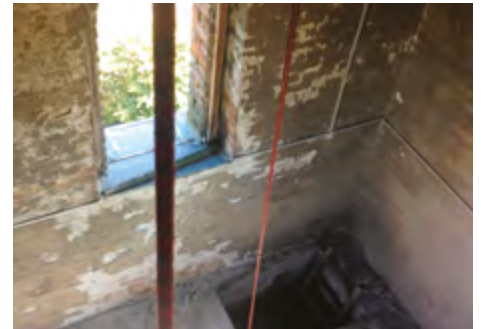
Particolari della torre campanaria.
