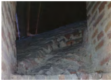
Accesso al sottotetto (si nota la curvatura della volta absidale) che permette di salire alla torre campanaria.
