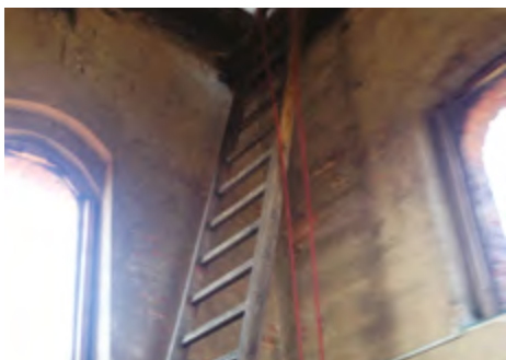
Particolari della torre campanaria.
